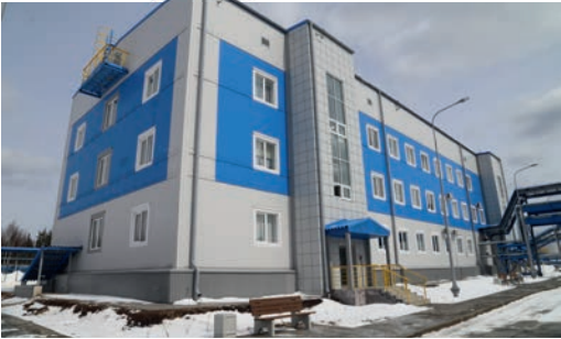
В 2024 году рядом с УКПГ-1 построили вахтовый жилой комплекс с общежитием на 130 мест
