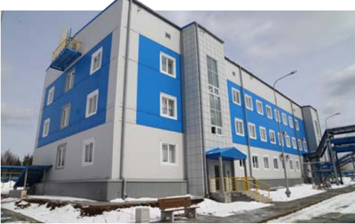
В 2024 году рядом с УКПГ-1 построили вахтовый жилой комплекс с общежитием на 130 мест
