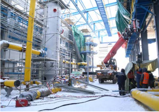
А еще год назад на «Единце» кипела стройка на каждом шагу
