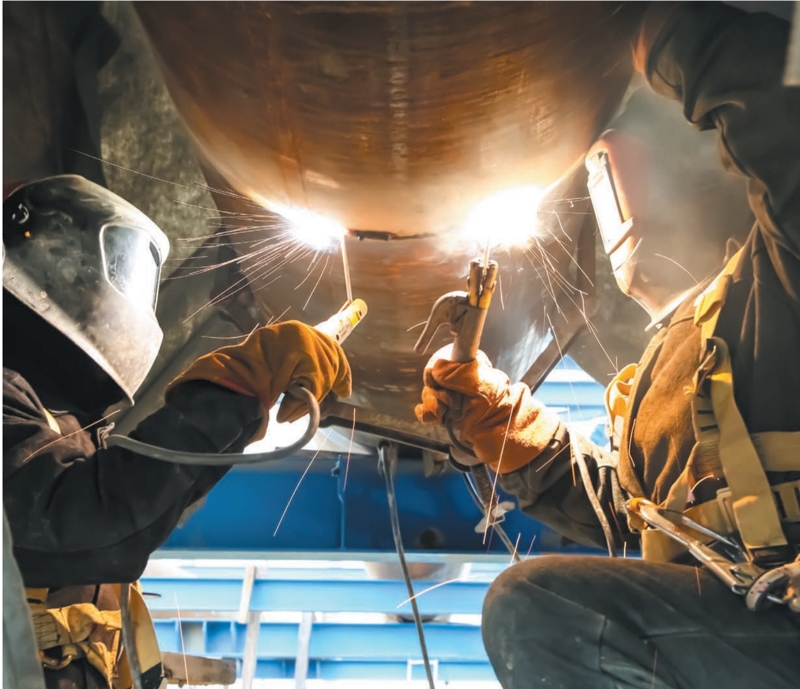
На площадке строительства установки комплексной подготовки газа УКПГ-2 Ковыктинского месторождения
