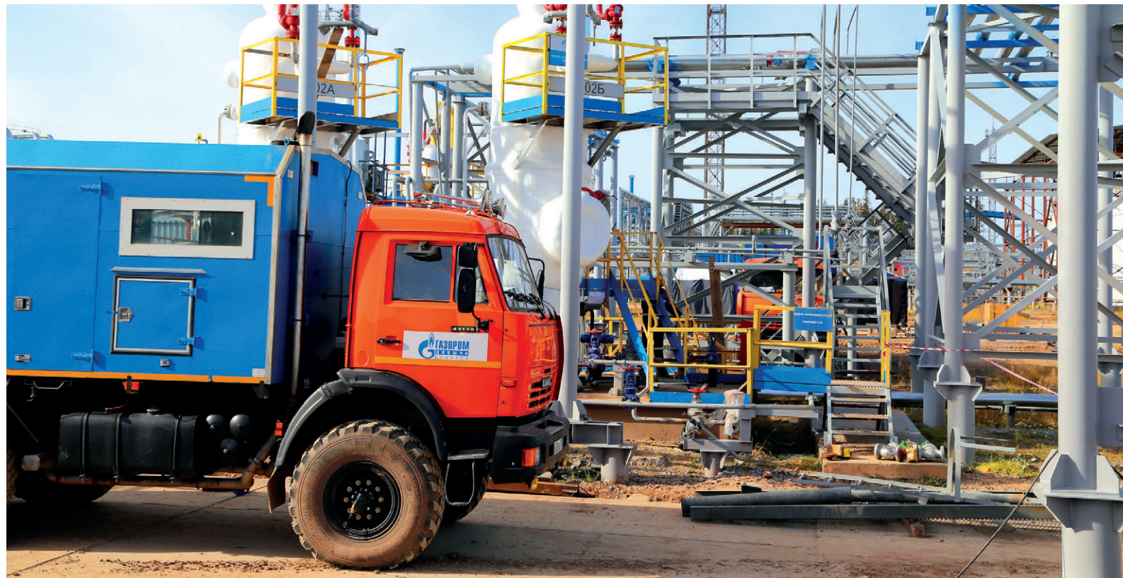
Площадка УПГ-102 после планового ремонта
