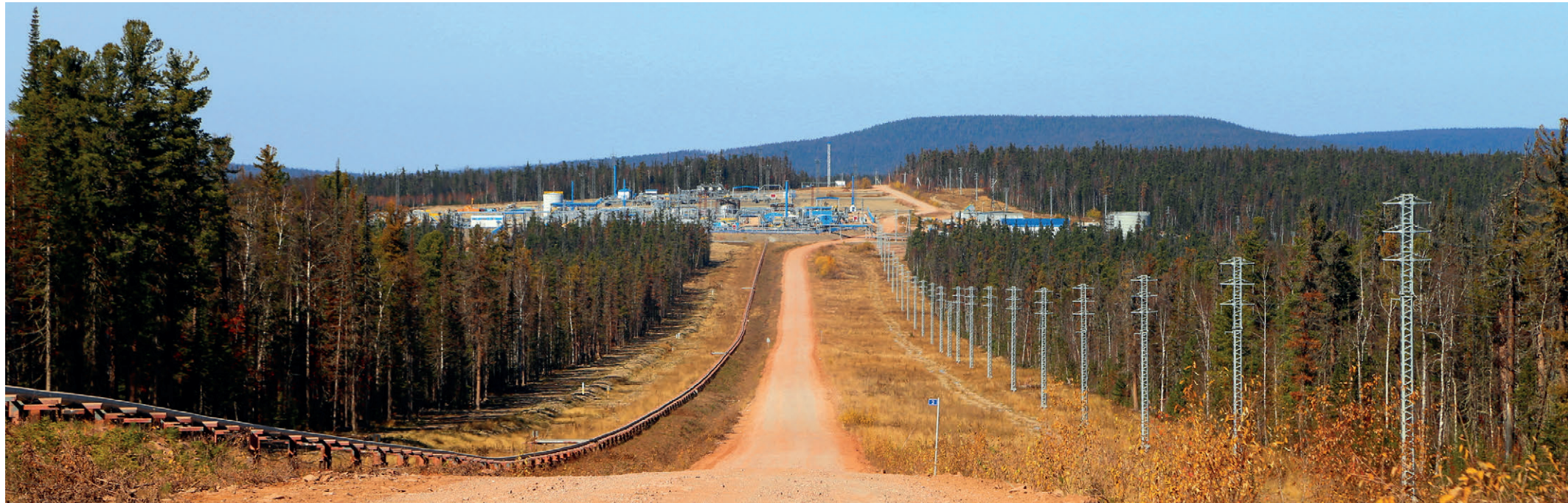
Внутрипромысловая автодорога к установке подготовки газа УПГ-102
