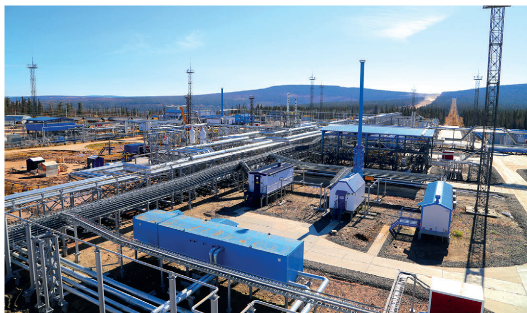
На Газовом промысле Ковыктинского месторождения
