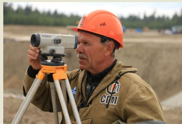
Работник подрядной организации напоминает оператора с видеокамерой. Но, конечно же, задача у него совсем другая – проверить проектные высотные отметки при помощи нивелира.
