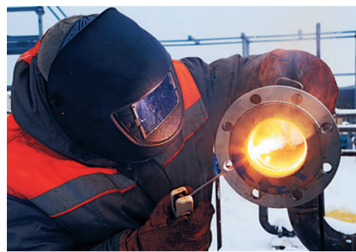
Строительно-монтажные работы на площадке УПГ-102. Январь 2017 г.
