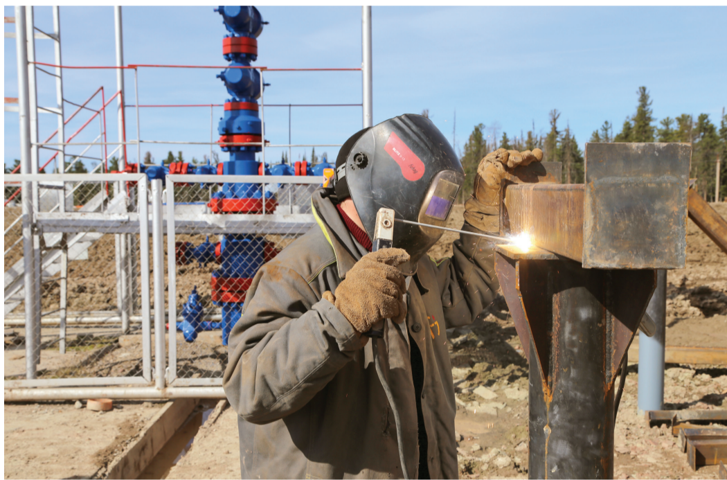
Работы по обустройству куста № 106 Ковыктинского месторождения
