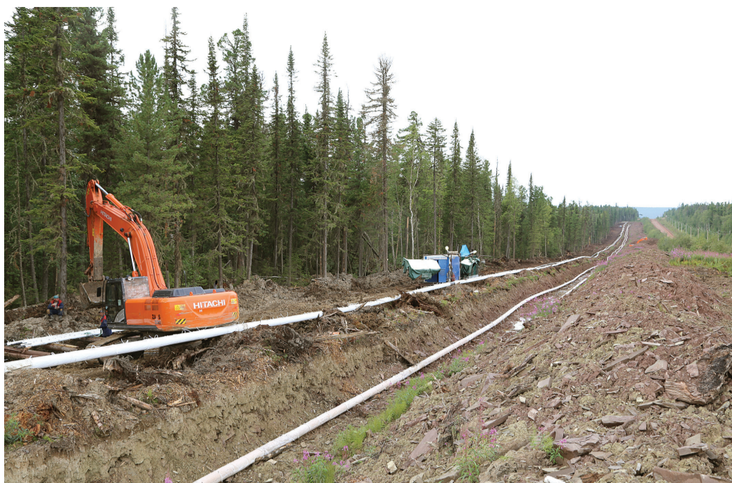
Строительство газопровода-шлейфа от куста № 106 до УПГ-102 Ковыктинского месторождения
