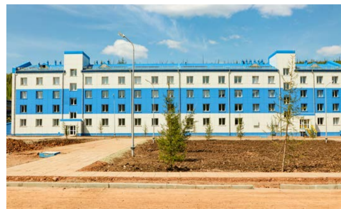
Одно из двух новых общежитий, построенных на территории нового вахтового поселка Нючакан
