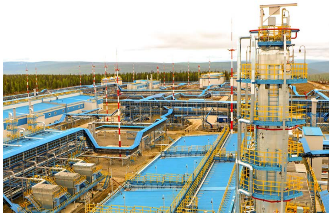
УКПП-2 — это первая из четырех установок комплексной подготовки газа Ковыктинского ГКМ. Ее мощность — 6,9 миллиарда кубометров газа в год
