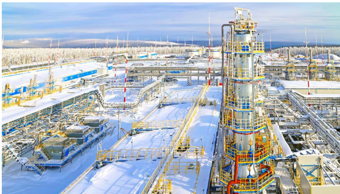
>>> стр. 2 На площадке установки комплексной подготовки газа № 2 Ковыктинского газоконденсатного месторождения
