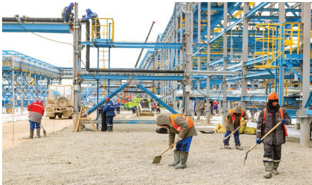
В строительстве УКПГ-2 участвовало несколько тысяч человек
