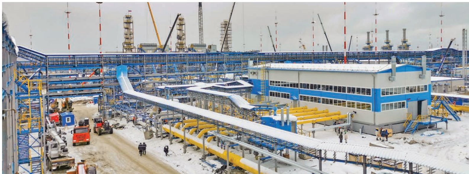
Еще полтора года назад здесь был участок земли, а сегодня построен сложнейший технологический комплекс, расположенный на площади 800 000 квадратных метров
