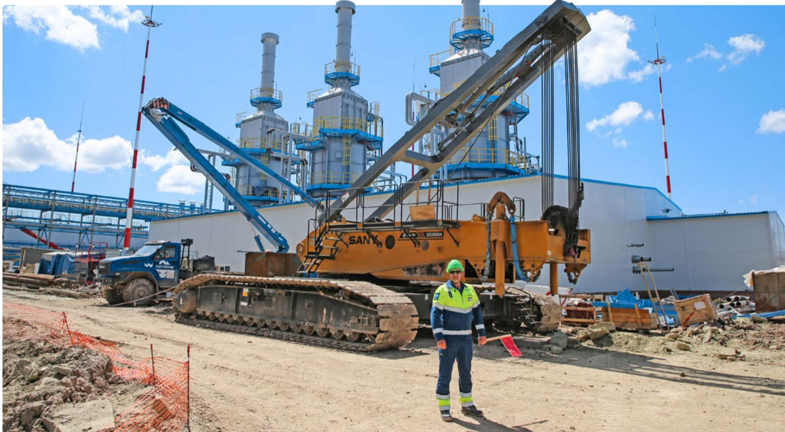
С площадки установки комплексной подготовки газа УКПП-2 будет подан первый ковыктинский газ в газопровод «Силы Сибири»
