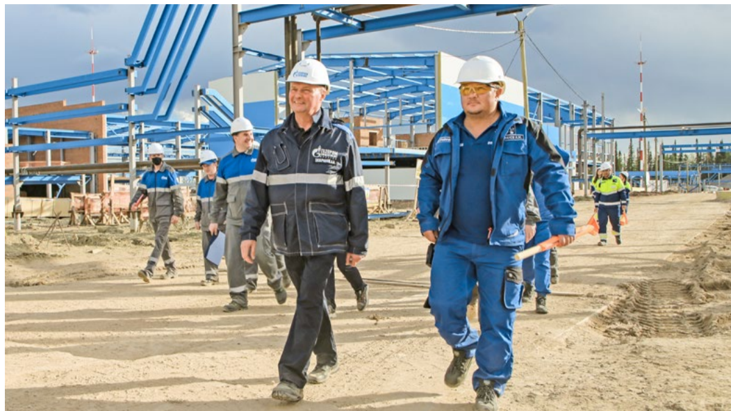
Площадка УКПП-3: строительство идет полным ходом
